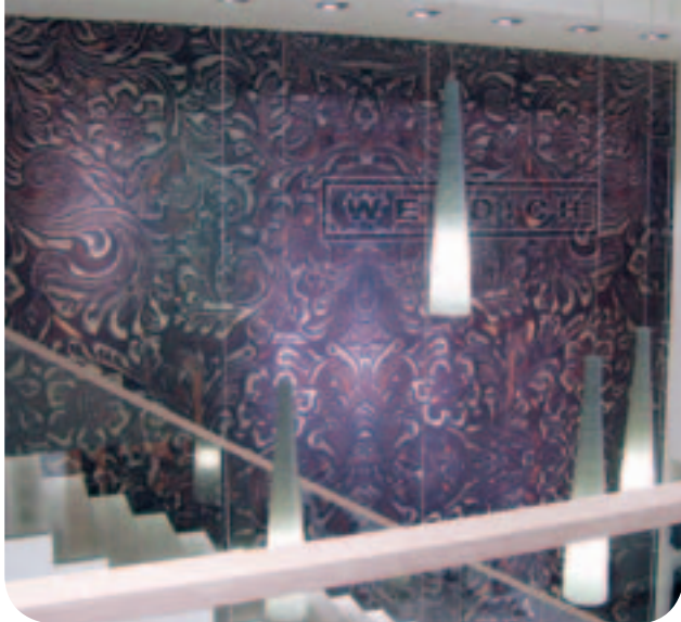
Textile Wandbespannung verbessert die akustische Qualität im Treppenhaus des Schuhgeschäftes Werdich
